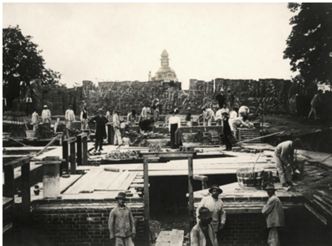
Pracovní ruch na staveništi, za stavebním materiálem špička věže Hanavského pavilonu, fotografie, kolem 1912. // Working bustle on the building site, with the roof of the Hanavský Pavilion peeking out from behind the stacked construction material, photograph, around 1912.
