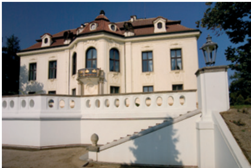
Pohled na Kramářovu vilu z jihovýchodu, fotografie, 2006. // View of the Kramář Villa from the south-east, photograph, 2006.
