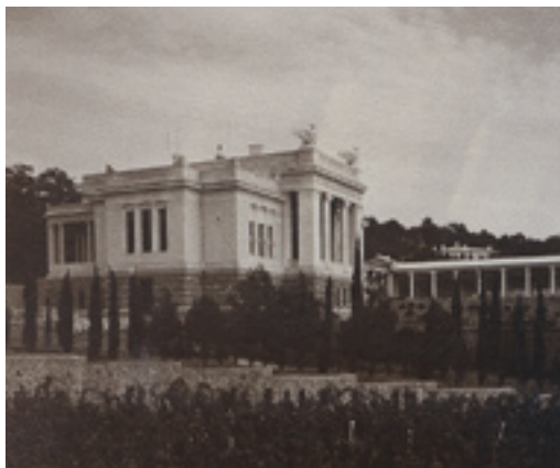
Vila Barbo od západu, fotografie, asi 1918. // Villa Barbo, view from the west, photograph, around 1918.
