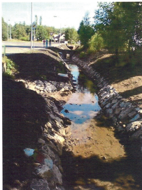
Stav po realizaci
