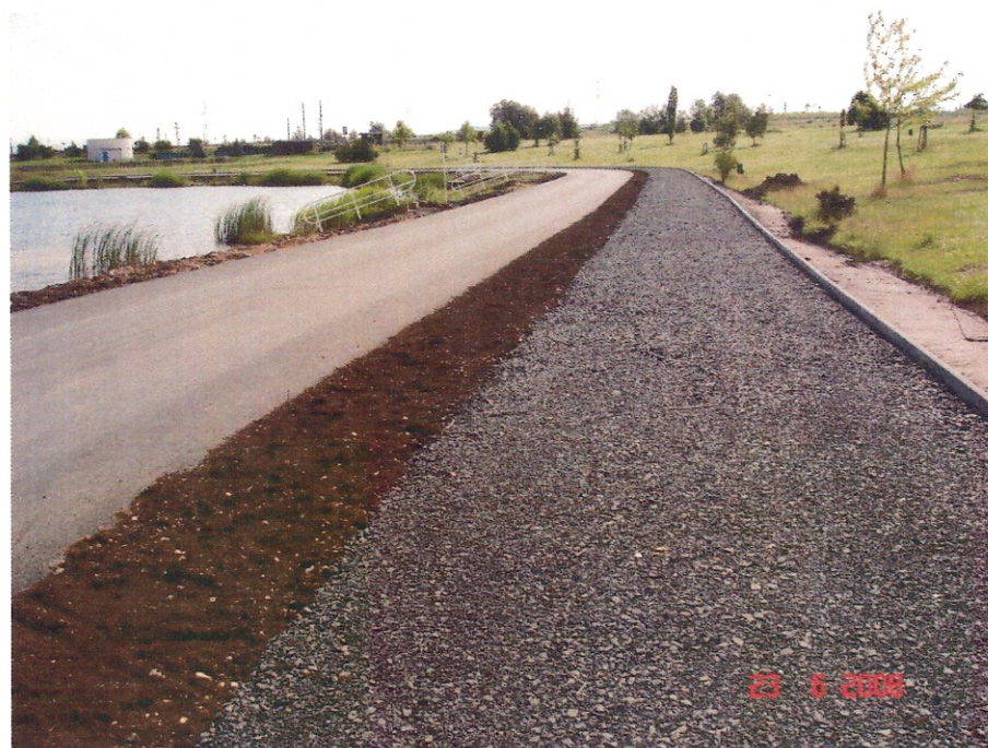
Stav po realizaci
