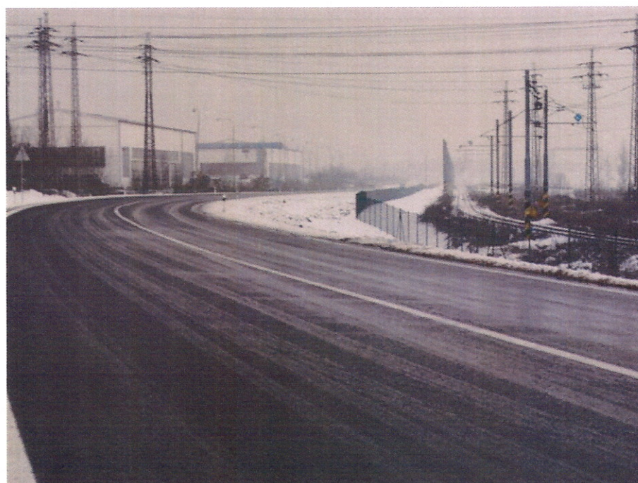
Stav po realizaci
