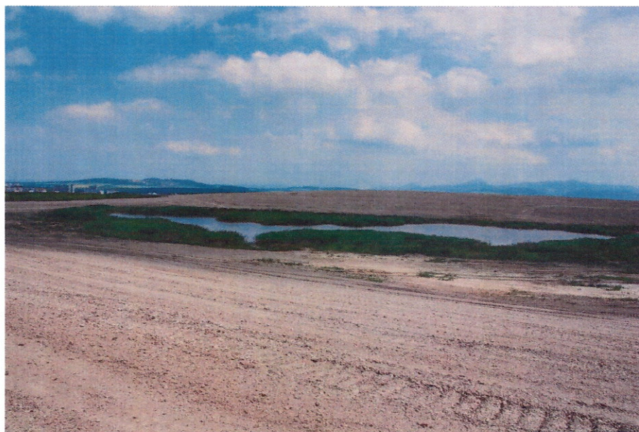
Stav po realizaci
